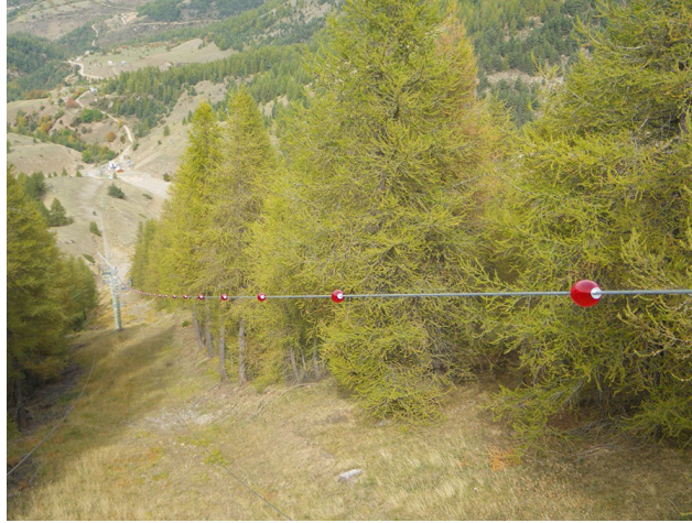
Installation de flotteurs de protection de l'avifaune à Valberg
