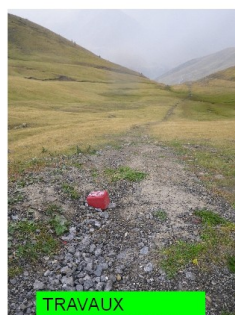
TRAVAUX ENTERREMENT LIGNE REFUGE 29/8/11
