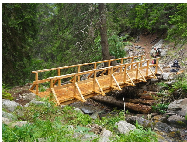
Rénovation passerelle de l'Erps (Vésubie)
