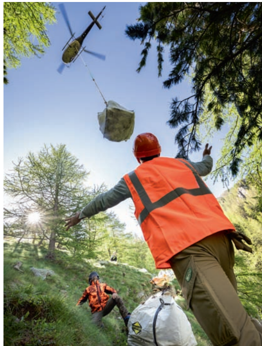
L'hélicoptage est parfois nécessaire pour faire parvenir des pierres et du matériel sur les sites.
