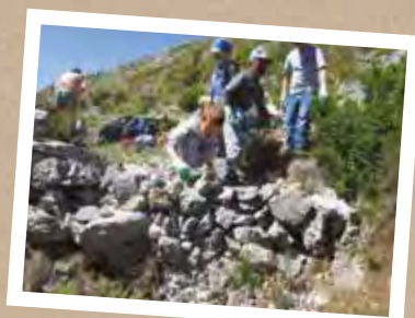
Réparation à l'ancienne d'un mur du sentier
